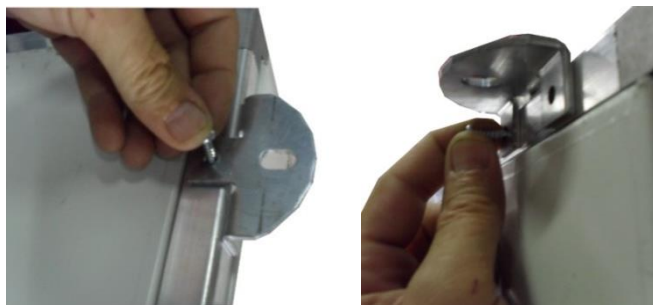
Figura 1 - Fissaggio delle staffe fornite a corredo
